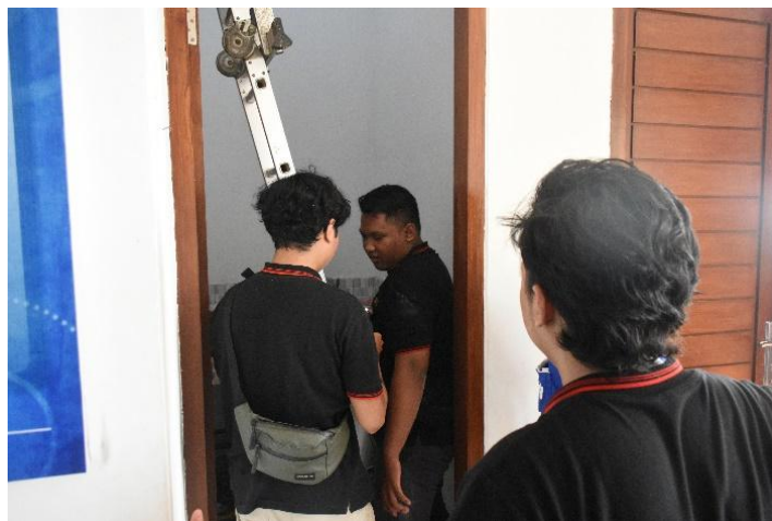
Gambar 2. Proses Persiapan Pemasangan Alat
